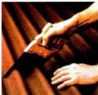
La placa Onduline es un material extremadamente resistente, ligero y ondulado, realizado a base de fibras orgánicas saturadas con bitumen y formadas bajo alta presión y temperatura. Se cortan fácilmente con serrucho, sierra o caladora.
